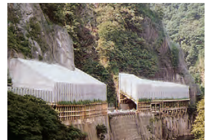
落石の衝撃を弱めるために、ロックシエッドの上に積み上げたEPSブロック。
