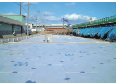
軟弱地盤で盛土荷重による荷重軽減工法として採用され、近隣建物の引込み沈下を抑制した施工事例。
