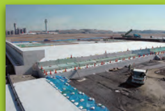
道路資材(EPS土工法)
