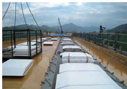
コンクリート橋の床版の軽量化の為、EPSを内型枠として使用します。(橋梁ボイド)
