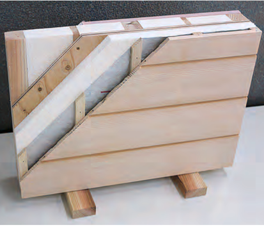
木造軸組/枠組「防火構造30分認定」を取得
