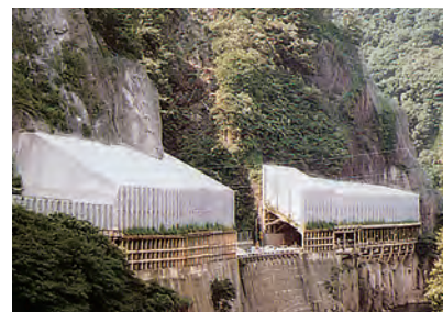
落石の衝撃を弱めるために、ロックシェッドの上に積み上げたEPSブロック。
