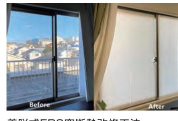
着脱式EPS窓断熱改修工法
