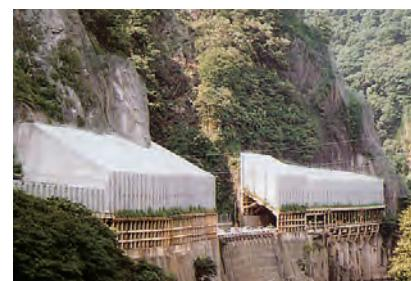
落石の衝撃を弱めるために、ロックシェッドの上に積み上げたEPSブロック。
