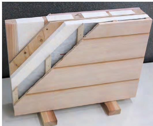
木造軸組/枠組「防火構造30分認定」を取得
