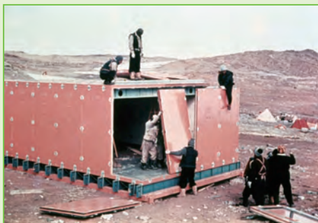
第一次南極観測隊昭和基地の建設風景
