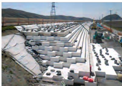
道路の盛土、拡幅工事の採用事例。多くの実績があります。
