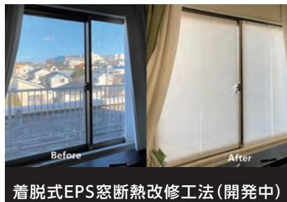
着脱式EPS窓断熱改修工法(開発中)
